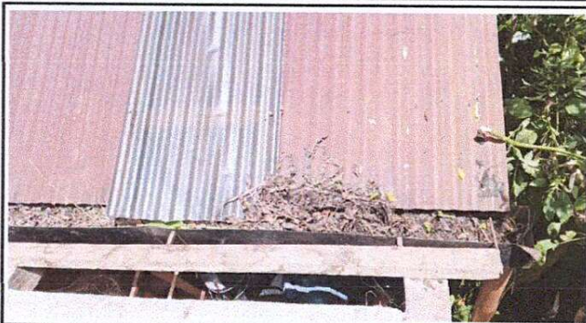
Foto 1: TRABAJO EN PROCESO DE CUBIERTA DE LAMINAS Y ESTRUCTURA DE TECHO DIRECCION
